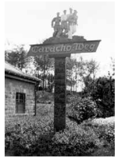
Wegweiser am Carachoweg. SS-Foto 1943
